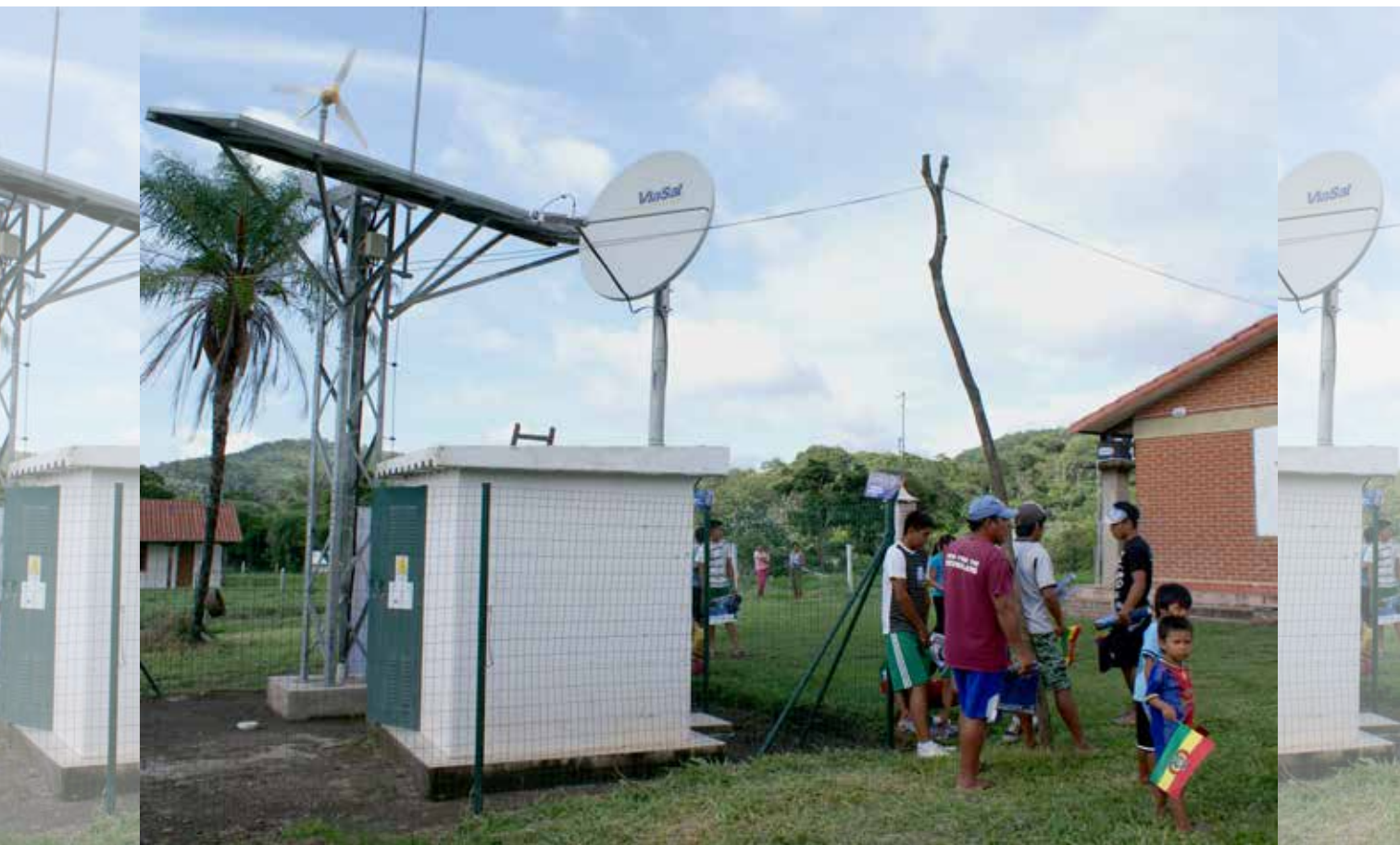
Sistema híbrido de suministro eléctrico
